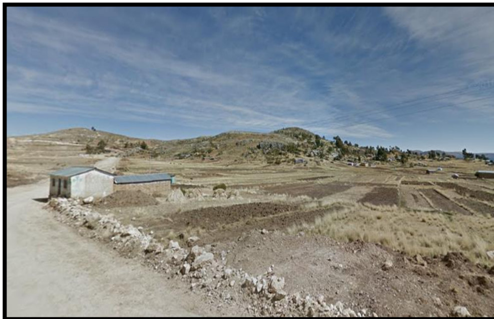
FIGURA N° 1: Estado actual de construcción de estructura adobe
